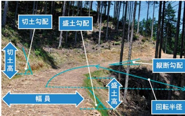
図1 道路の幾何構造
