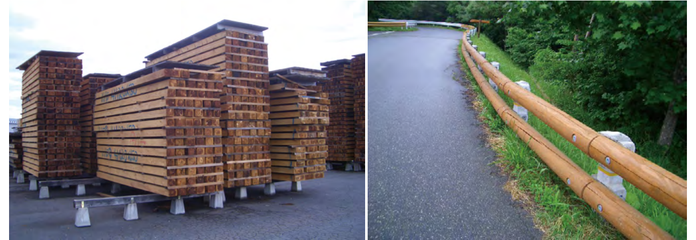
写真1 棧積みした平角(左)と木製ガードレールビーム(右)
