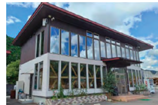
図3 FCF塗料を使用した試験施工例(上部有色部)
