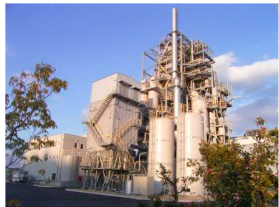
写真5. 大規模蒸気式発電施設
