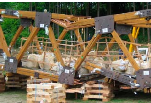
写真5 下流側上弦材の圧壊 (最終破壊)
