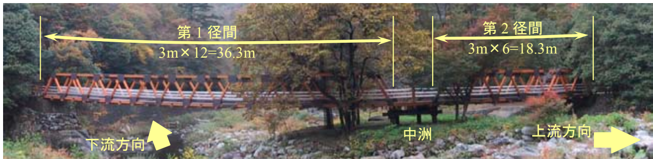
写真1 解体前の木橋 (2003/11/06 撮影)
