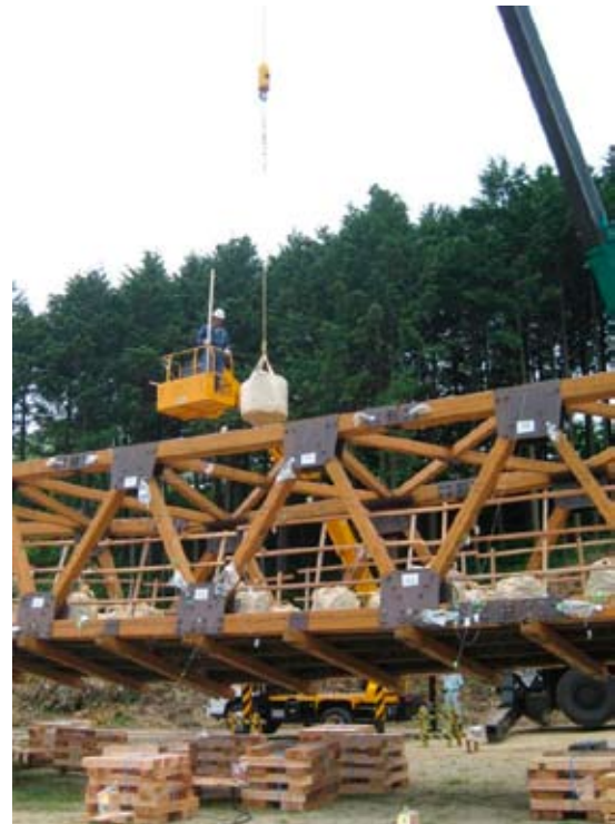
写真3 クレーンで土嚢を載せる
