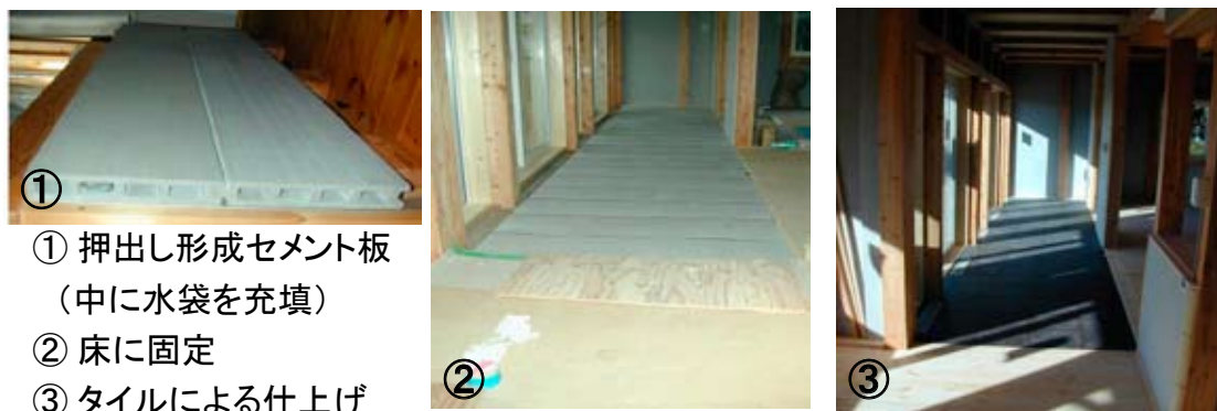
写真1 日射吸収蓄熱床
