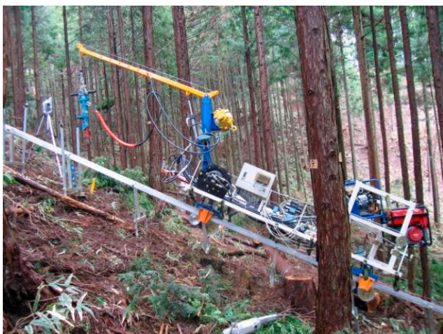
写真3 敷設装置と簡易レール
