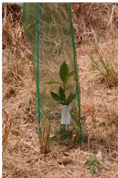
図3 森林環境税による土砂流出対策工事と広葉樹植林
