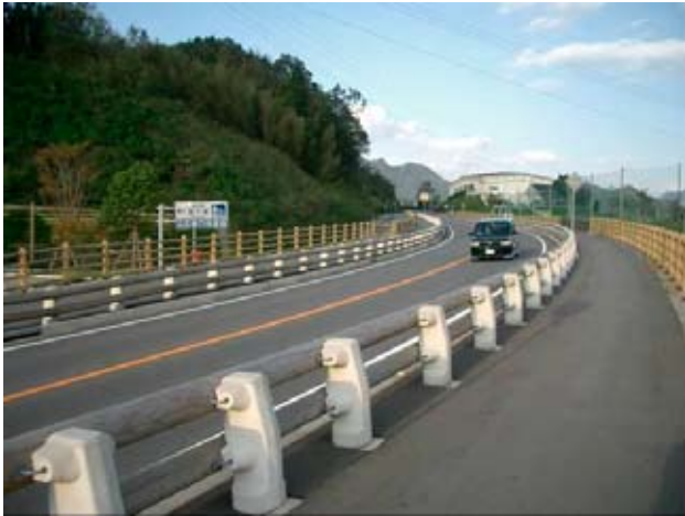
写真1 宮崎県に設置されている木製防護柵
