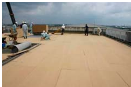
図 7. 保水資材を全面に設置
