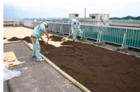
図 8. 土壌の設置 (土壌が少ない、簡便な施工)
