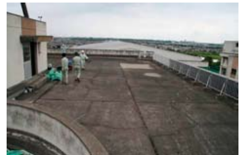
図 6. 緑化のために耐荷重を高めていない屋根
