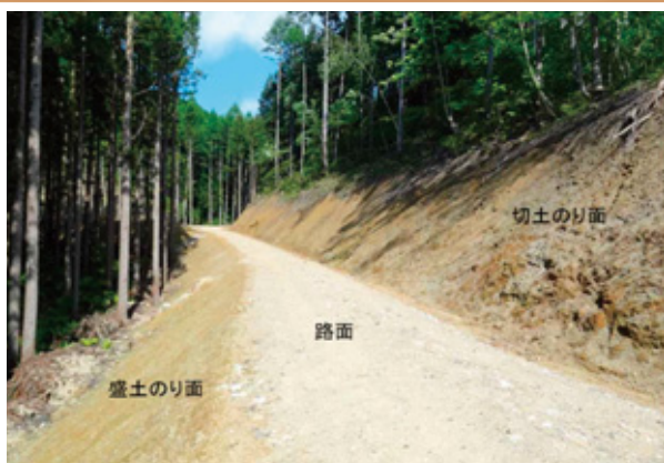
図1 林道の切土のり面、路面、盛土のり面
