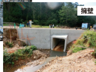
土木工事（左：谷止工、右：擁壁）での使用状況
