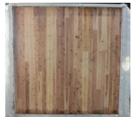
2時間耐火試験後も、内部 CLT 表面に炭化 はなく、十分な強度を保持した健全な状態
