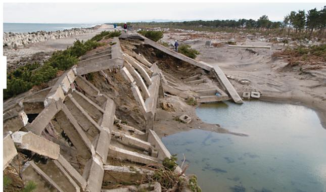
図1 破壊され背後が洗掘された防潮堤
