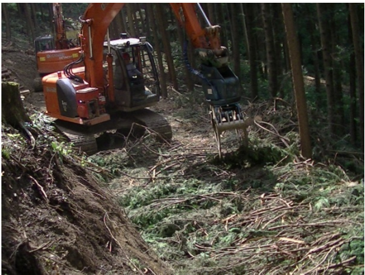
図7 グラップルを用いて路面を枝葉で覆う作業
