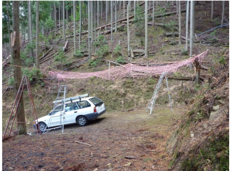
図2 ネットを車高より高く設置すれば、網の下を車が通行できます
