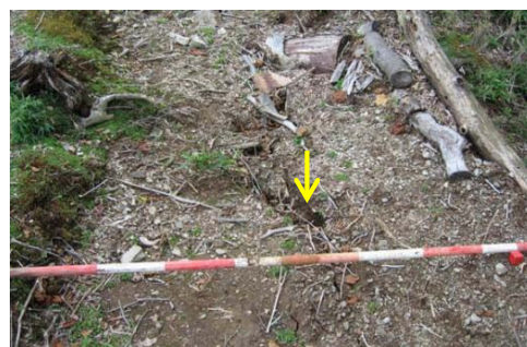
図4 崩壊地2の背後の稜線に発生した亀裂
