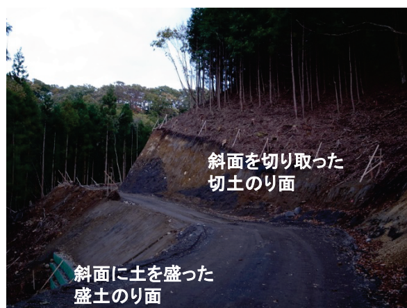
図1 施工中の林道
