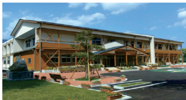
↑綾町立綾中学校 木造2階建一部RC造 延べ床面積約3,200㎡
