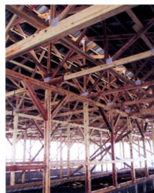
写真3. 建設中の繁殖牛舎内部 材料は全て宮城県産のスギ材
