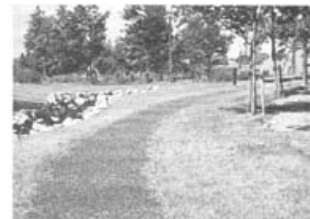
写真2. チップによる舗装（アスファルト乳剤混合工）
