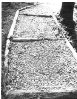
写真1. チップによる舗装（撒布工）
