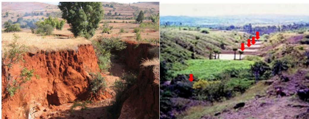
図 3-2-2 ミャンマーにおけるガリー侵食とチェックダムによる侵食の防止(左:シヤン州で見られるガリー. 右:中央乾燥地での UNDP/FAO によるガリー侵食対策としてのチェックダムを赤色矢印で示した)
