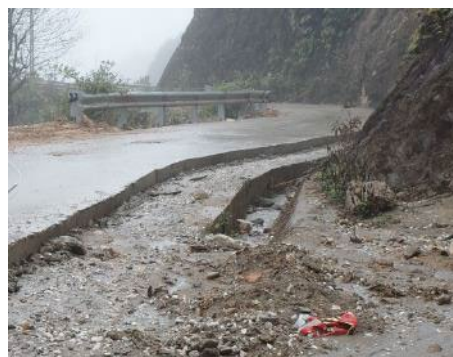
図 4-2-2-14 道路の舗装状況の一例. ここでは既存の古いコンクリート舗装面上に新しいコンクリート舗装が重ね張りされていた
