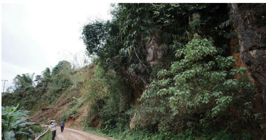
図 4-2-2-9 石灰岩分布域の急勾配斜面(手前側). 隣接する斜面崩壊②に比べてさらに急勾配を呈し岩が露出するが斜面崩壊は発生していない
