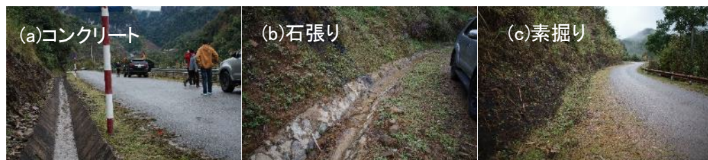
図 4-2-2-13 道路沿いに作設された排水溝. 種類(材料)はコンクリート、石張り、素掘りに分類される
