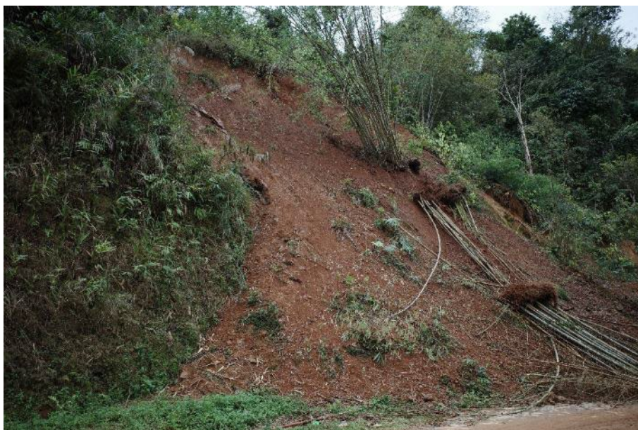
図 4-2-2-5 堆積岩(泥岩・頁岩)分布域で発生した斜面崩壊②(ソララ省モンゾンコミュニティ)
