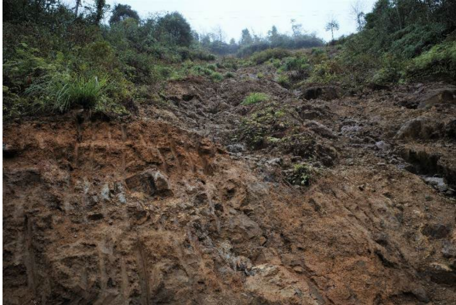
図 4-2-2-3 流紋岩分布域で発生した斜面崩壊①(イエンバイ省ムーカンチャイ県)
