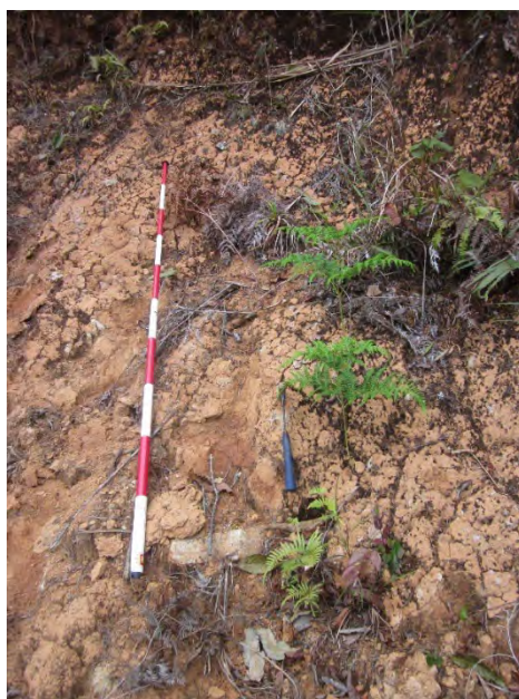
図 4-3-3-7 Mu Chang Chai District (KimNoi Commune ほか) の崩壊地(露頭)の状況
