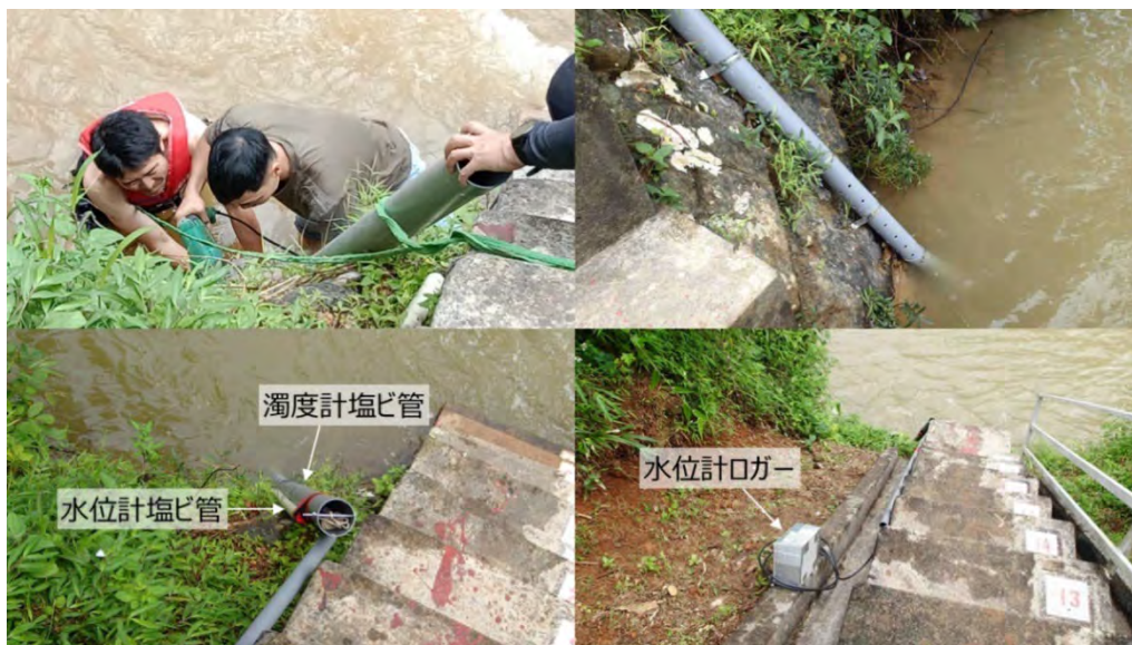
図 4-2-2-4 水位計及び濁度計設置工事(2022 年 9 月)
