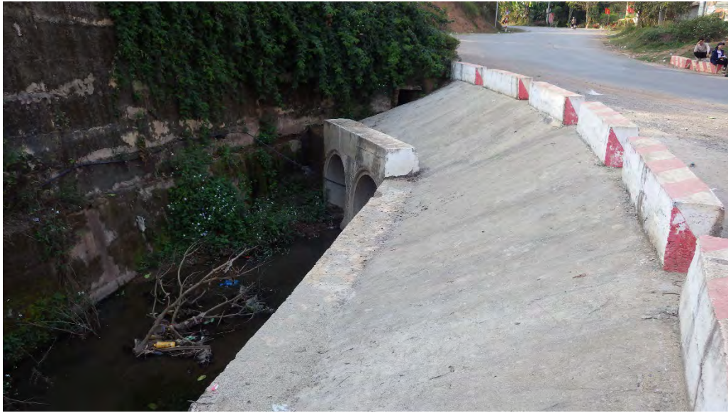
図 4-2-2-21 Muong Gion Commune における国道 279 号線と県道 107 号線を横断する橋
