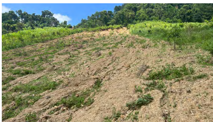
図 4-2-2-3 表面の土層が流出するタイプの崩壊。この崩壊地は、樹木が伐採されたトウモロコシ畑などの耕作地で発生していることが多い。
