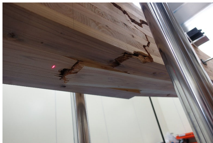
写真 7-3-9 DOL-90-1 梁下端フィンガージョイント部破断②
