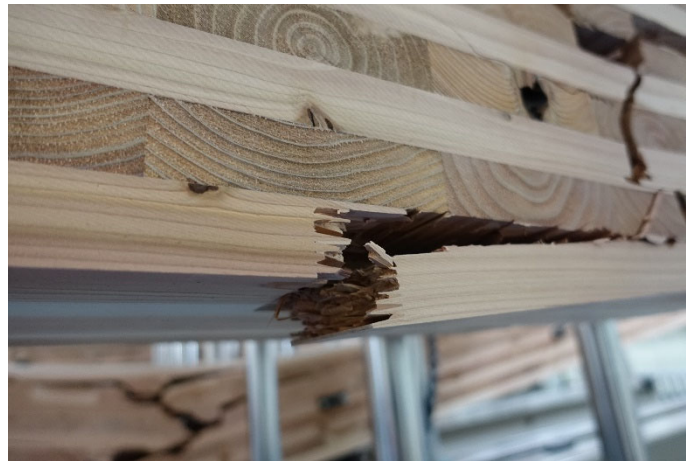
写真 7-3-8 DOL-90-1 梁下端フィンガージョイント部破断①
