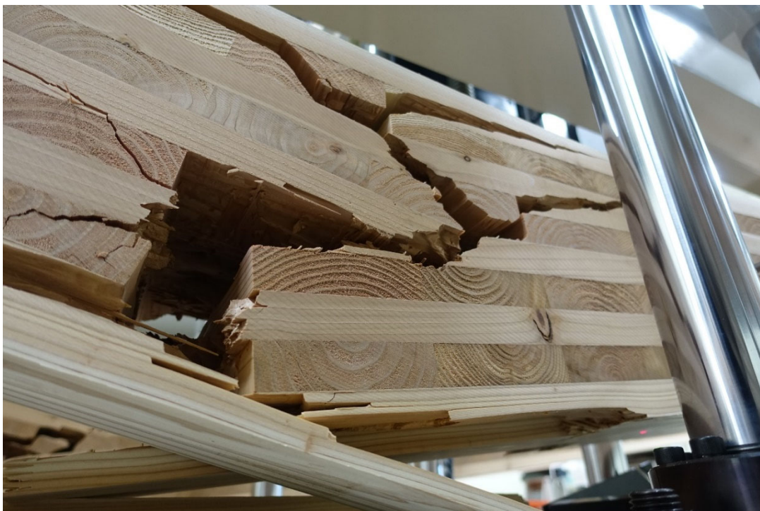
写真 4-3-2 DOL-94-1 破断状況
