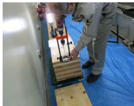
図 3-2-4 先孔切削作業の状況
