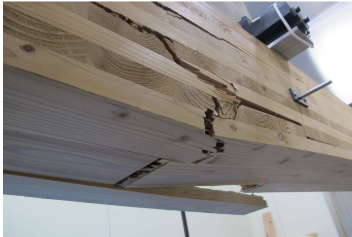
写真 7-2-20 DOL-90-3 破壊状況②
