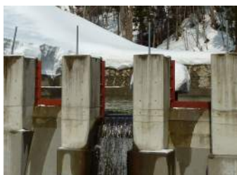
写真1 矩形堰 量水堰の例
