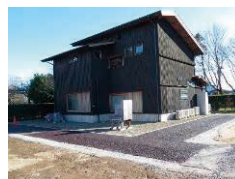
図2 試験施工例（森林総合研究所）
