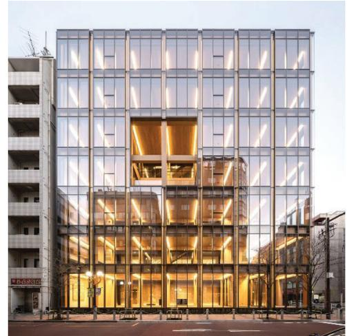
図1 成果である耐火集成材の実用例：ジューテック本社ビル（東京都港区新橋）
