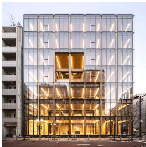
図1 成果である耐火集成材の実用例：ジューテック本社ビル（東京都港区新橋）
