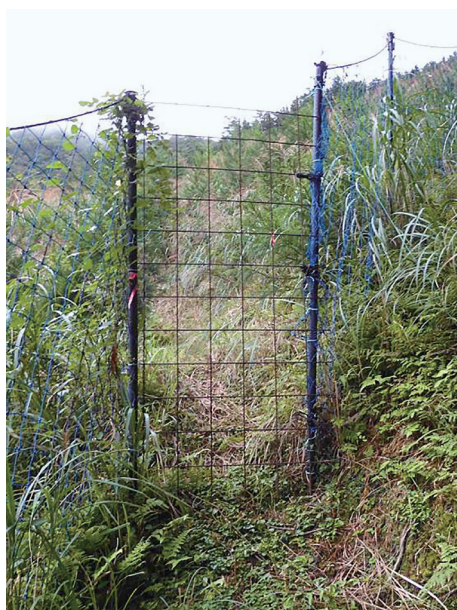
写真1. 防護柵の出入り口としてワイヤーメッシュが利用された例
