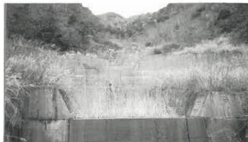
写真二 小豆事業区域 坂手地区仲人石山治山ダム群と山腹緑化工施工地
