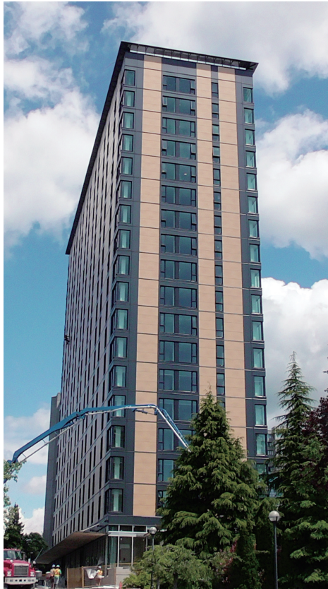
写真：CLT造18階建て学生寮（Brook Commons ビル） ブリティッシュコロンビア大学内にて【服部 順昭氏 撮影】
