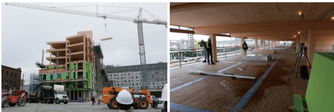
写真 CLT と集成材を用いた 8 階建て共同住宅の建設現場（モントリオール市内）
