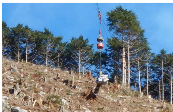
シカ防護柵の運搬
