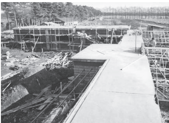
庁舎の建設(庁舎側から渡り廊下方向)
