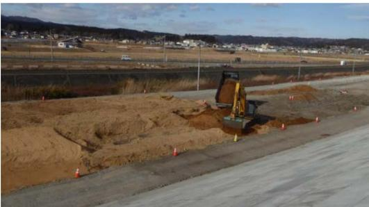
写真7 “締固めない盛土” 施工状況（前浜地区）
