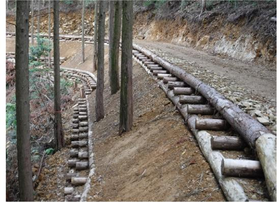
写真5 丸太組工法(のり留工)による作業道
