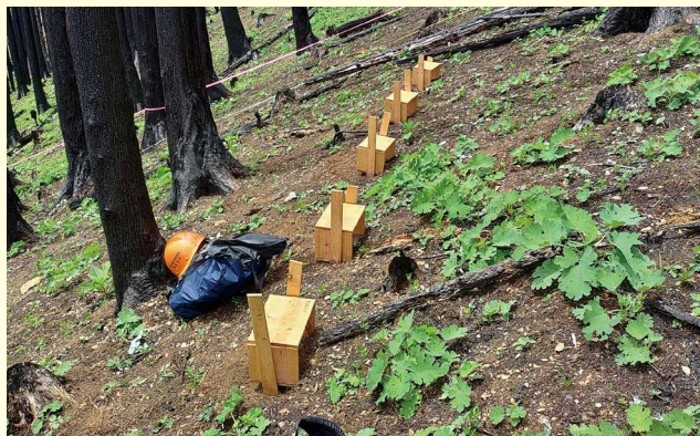
写真-1 土砂受け箱設置の様子 (八ヶ森緩斜面、2025年7月)
