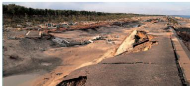
防潮堤の背面（内陸側）は越流した津波で洗掘され、海岸林は地面ごと流失、防潮堤もまた損壊した。林内には損壊した防潮堤の構成材料が入り込んだ。
