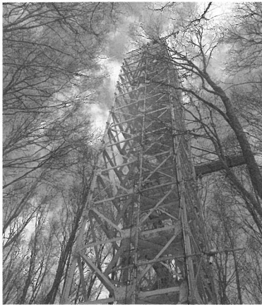
写真2 安比試験地内の二酸化炭素吸収量観測のためのタワー
