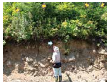
写真2：切土法面にみられる薄い土壌と厚い石礫層 白色の矢印は赤白ポール、黄色の矢印はスギの植栽木
