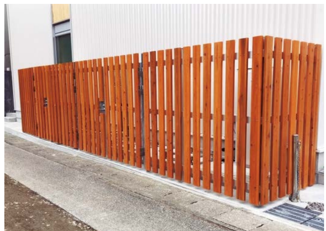
図4 CNFシーラーを使用した木製外構柵の試験施工 (高知県嶺北森林管理署)
