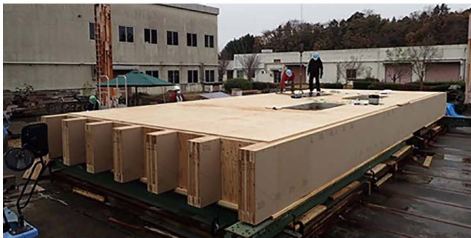
図4 高性能のはり部材による実大床
