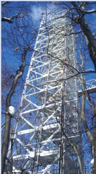
林内に設置された高さ31mの観測タワー
