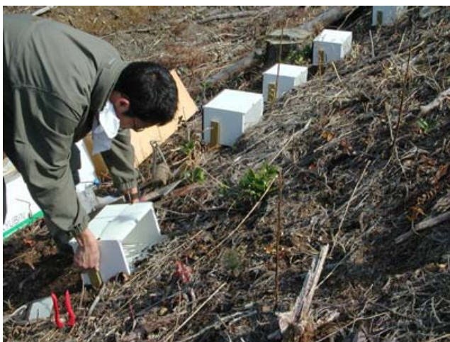
写真4-1 土砂受け箱の設置の様子
