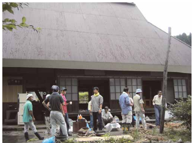
写真 2-3-2 改装中の拠点民家
