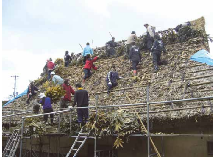
写真 2-3-4 屋根の葺き替え作業の様子
