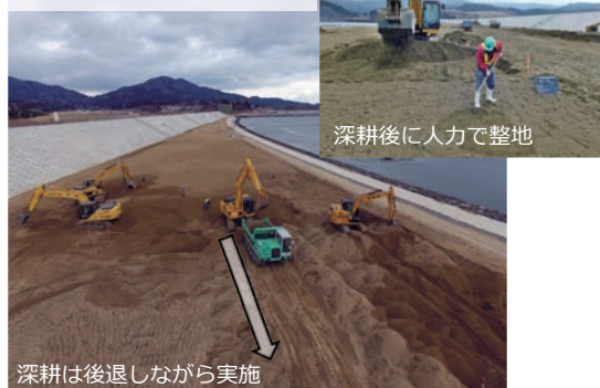
図3 「締め固めない盛土工」の施工風景：岩手県陸前高田市（小野賢二（他）（2020）より引用）
