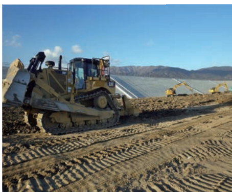
図3 「締め固めない盛土工」の施工風景：岩手県陸前高田市（小野賢二（他）（2020）より引用）
