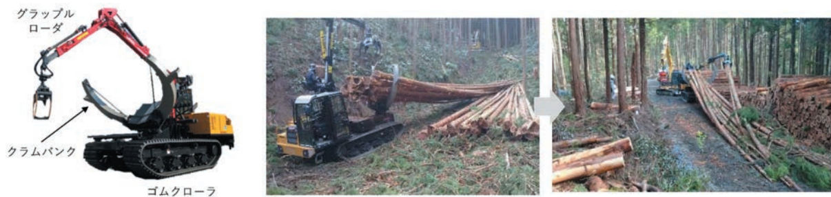
図1 ゴムクローラ式クラムバンクスキッドとそれを用いた全木集材作業
