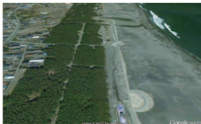
写真1 被災から約1か月後（H23.4.5）の状況 クロマツの針葉は緑色で、外観的には健全な状態と考えられていた。
