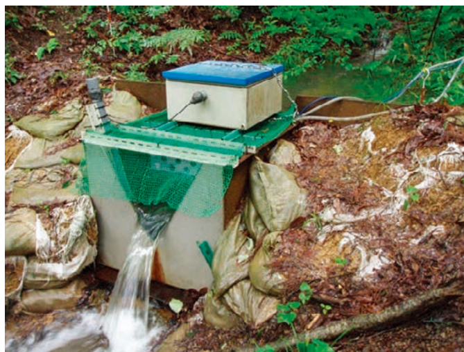
写真1 流出水量を観測するための堰
