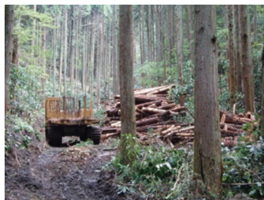
図4. 間伐実施中の作業道の様子
