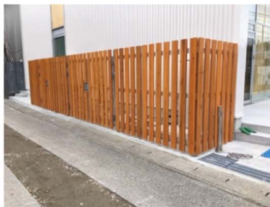
図5. CNF配合塗料を下塗りに用いて工場塗装した 木材で作製したフェンス(嶺北森林管理署)
