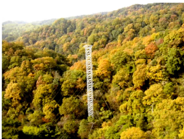
図2 森林総合研究所関西支所 山城試験地フラックス観測タワー
