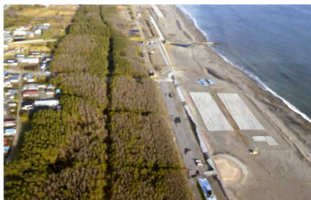
写真2 被災から約20か月後（H24.11.19）の状況 夏頃から針葉が赤褐色になる被害の生じたクロマツの多くが枯死し、針葉が脱落した。
