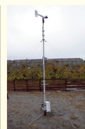
写真1 平坦部に設置した風向・風速計
