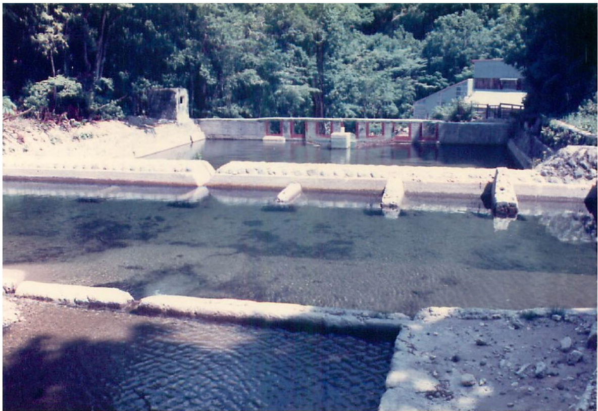
Photo 2. 上流側から見た初沢試験流域の土砂止堰堤、量水堰堤およびバザン式矩形ノッチ（1990年6月撮影）。中央の池が沈砂池、奥が湛水池
