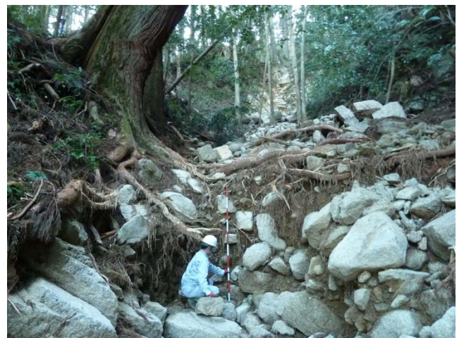
樹木根系が侵食を食い止めた例. 2011年災害時の那智大社裏斜面.
