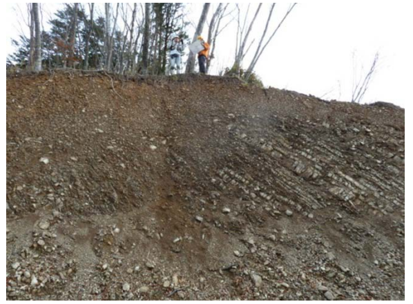
重力変形で破碎された岩盤. 左側では地層が不明瞭になっている
